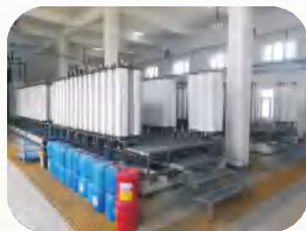
DTRO应用—8000m 3 /d江苏工业废水处理
