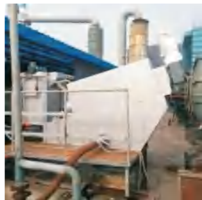
化工废水污泥脱水
